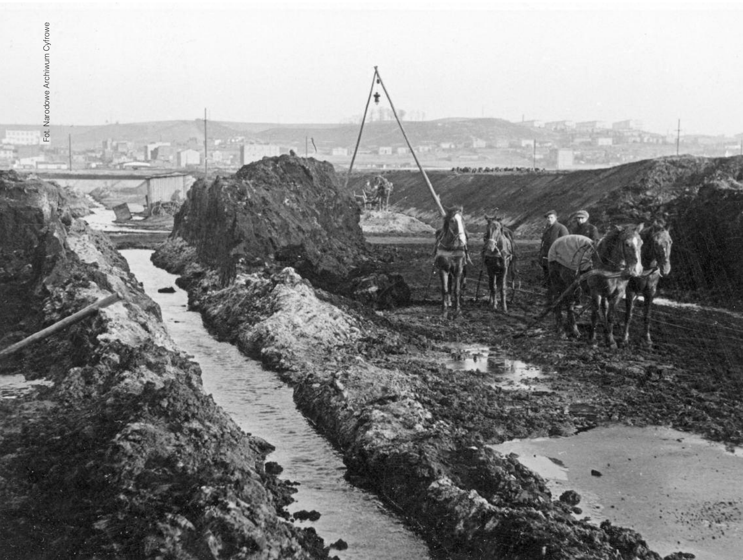
Budowa portu w Gdyni
