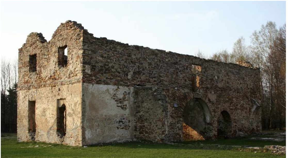
W 1817 roku w Samsonowie rozpoczęto budowę nowej huty; na zdjęciu ruiny wielkiego pieca
