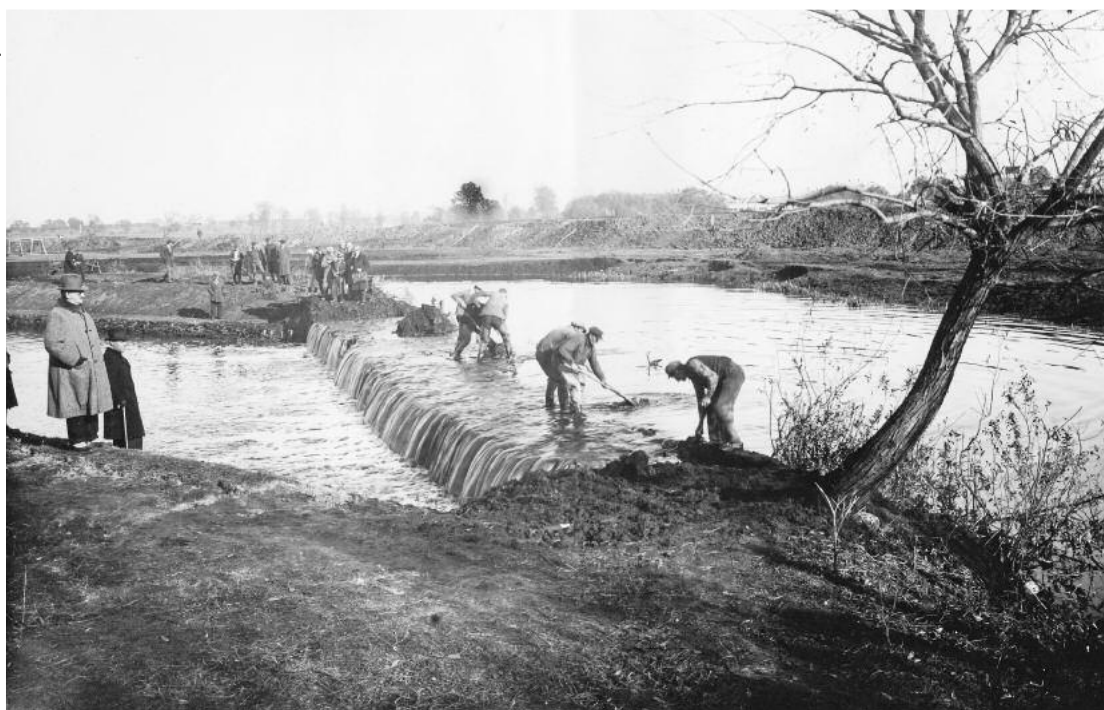
Prace przy regulacji Turii w Kowlu
